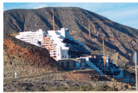
Kranerne står der endnu over det strandede hotelprojekt.
